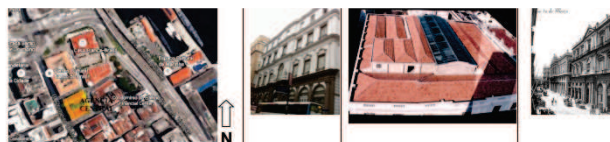
Figura 5 — Localização, fachada e cobertura da Agência Central. Rua 1º de Março (1890)
