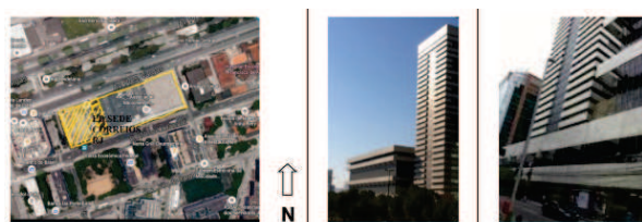
Figura 3 — Localização e fachadas do Ed. Sede/ RJ
